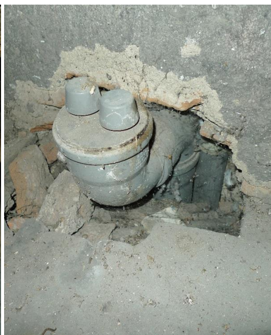
půdní prostor – vyvedení rekonstruované kanalizace a vody
